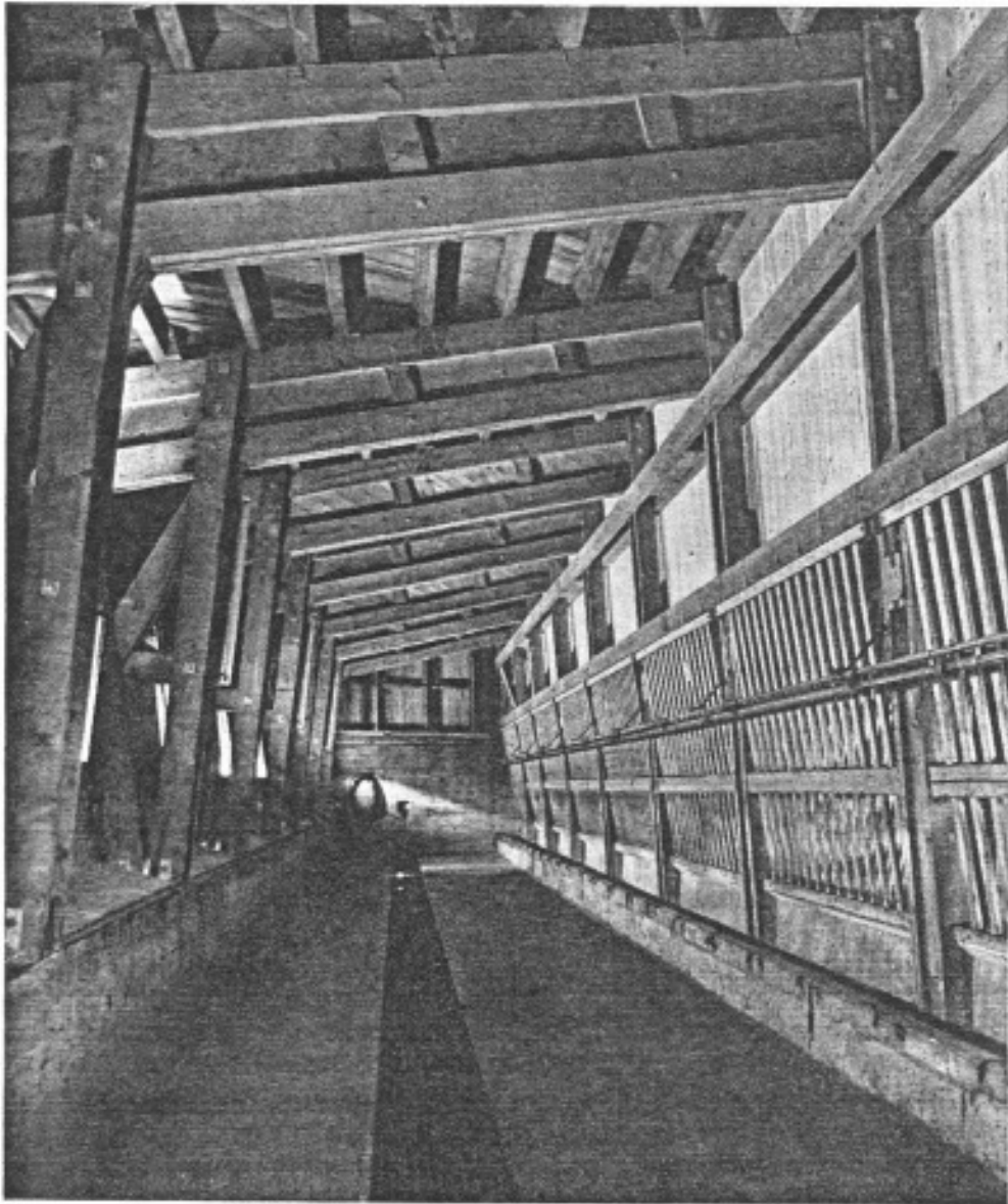
Stallung. Lager mit Schwemmentmistung Heuraufel und Milchabsaugleitung
